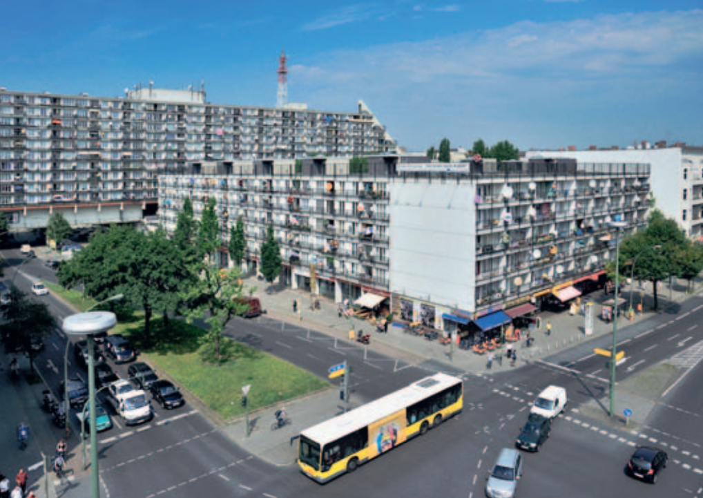
Pallasseum, Potsdamer Straße / Pallasstraße
